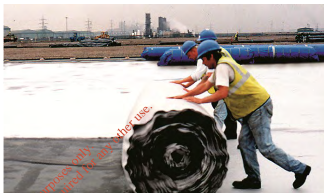
Fig. 2: Rolling out Pozidrain
