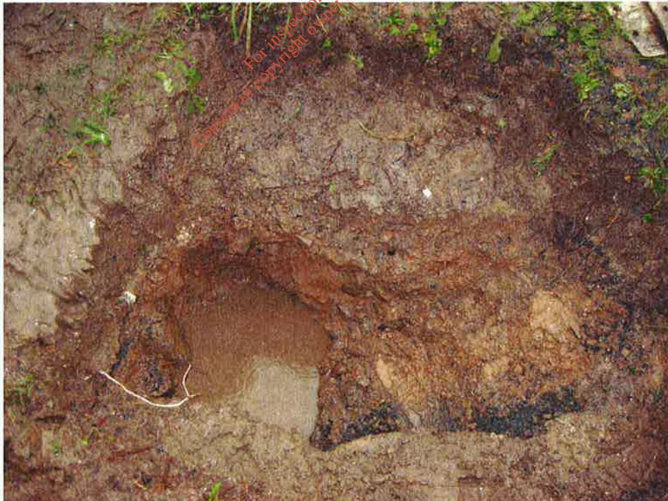
E12 Inspection Pit
