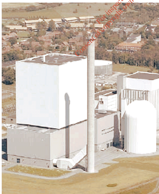
Figure 5.15 Elsam Kraft A/S Skærbæk Power Plant, Unit 3
